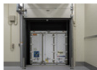
施設開口部と車両の隙間からの外気侵入を防ぐ ドックシェルター
