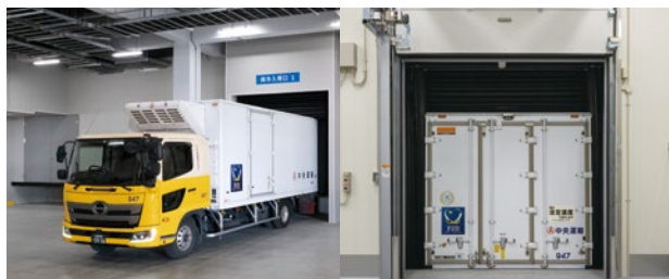
施設開口部と車両の隙間からの外気侵入を防ぐドックシェルター
